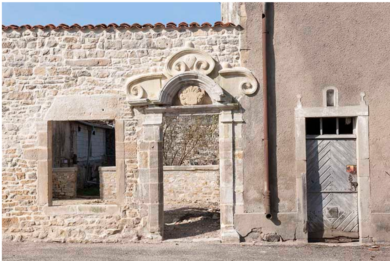
Porte reconstruite avec pierres de remploi.
