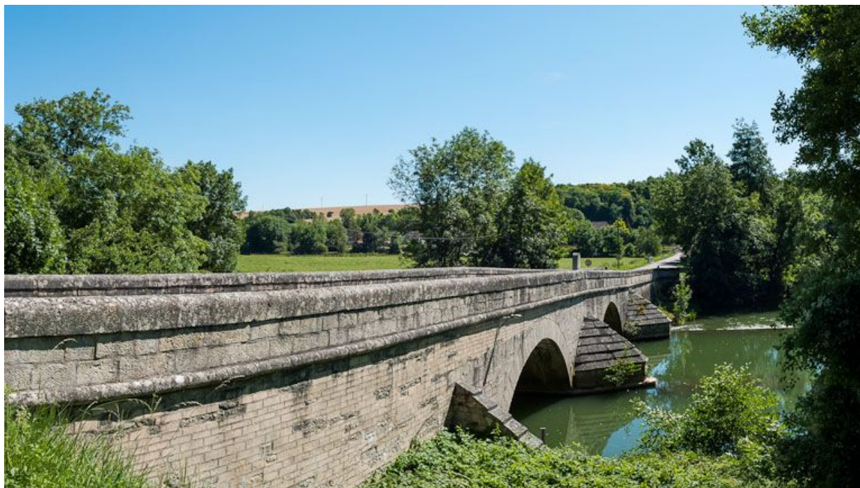
Pont sur l'Armançon.
