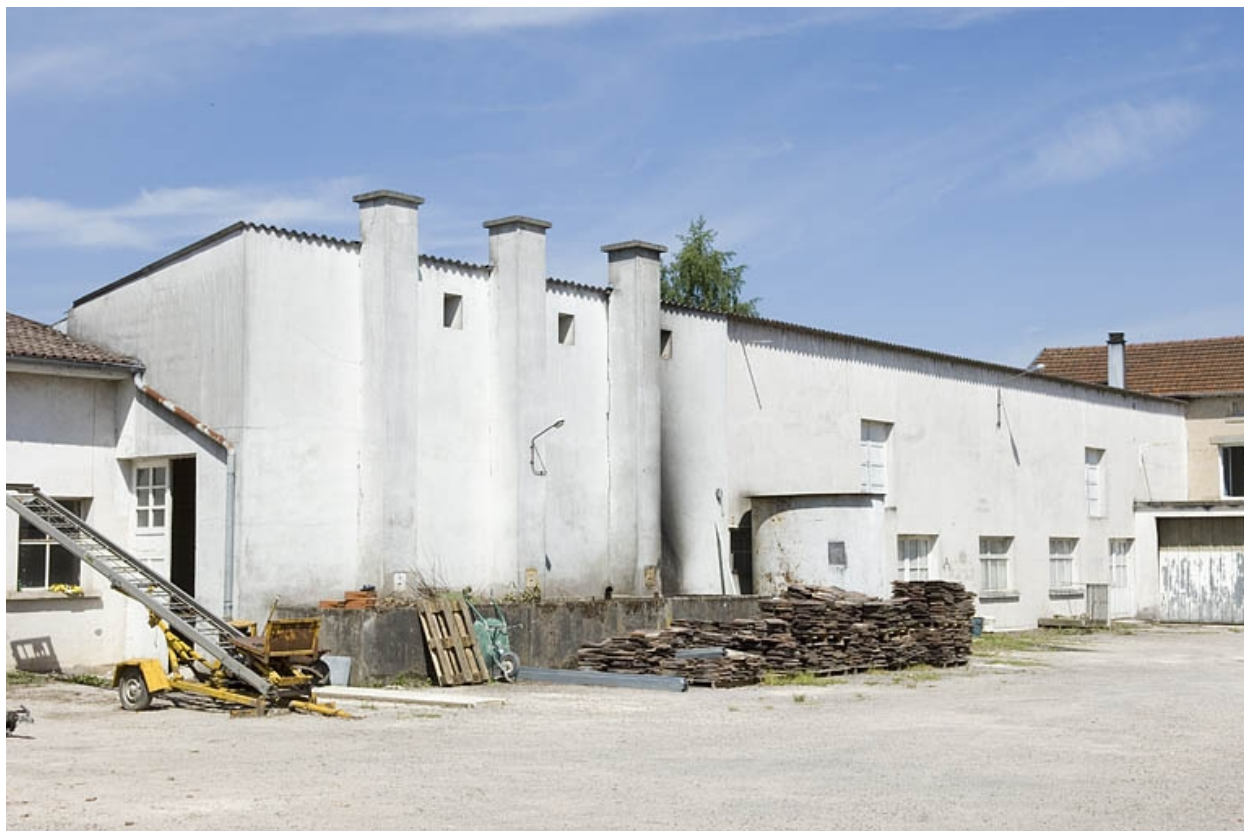
Salle de distillation moderne.
