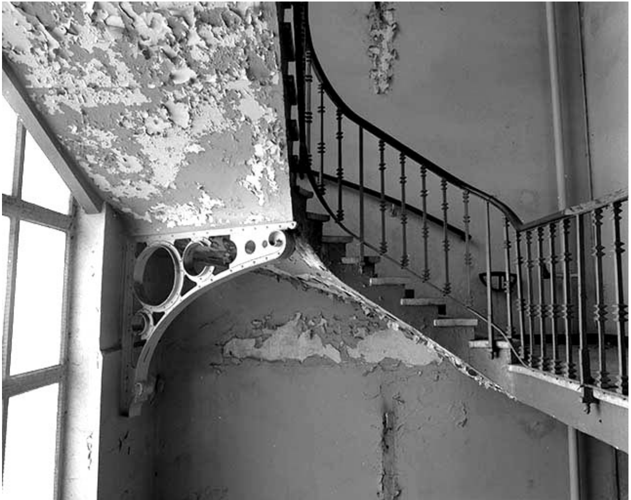
Escalier de la cantine : rampe et console.
