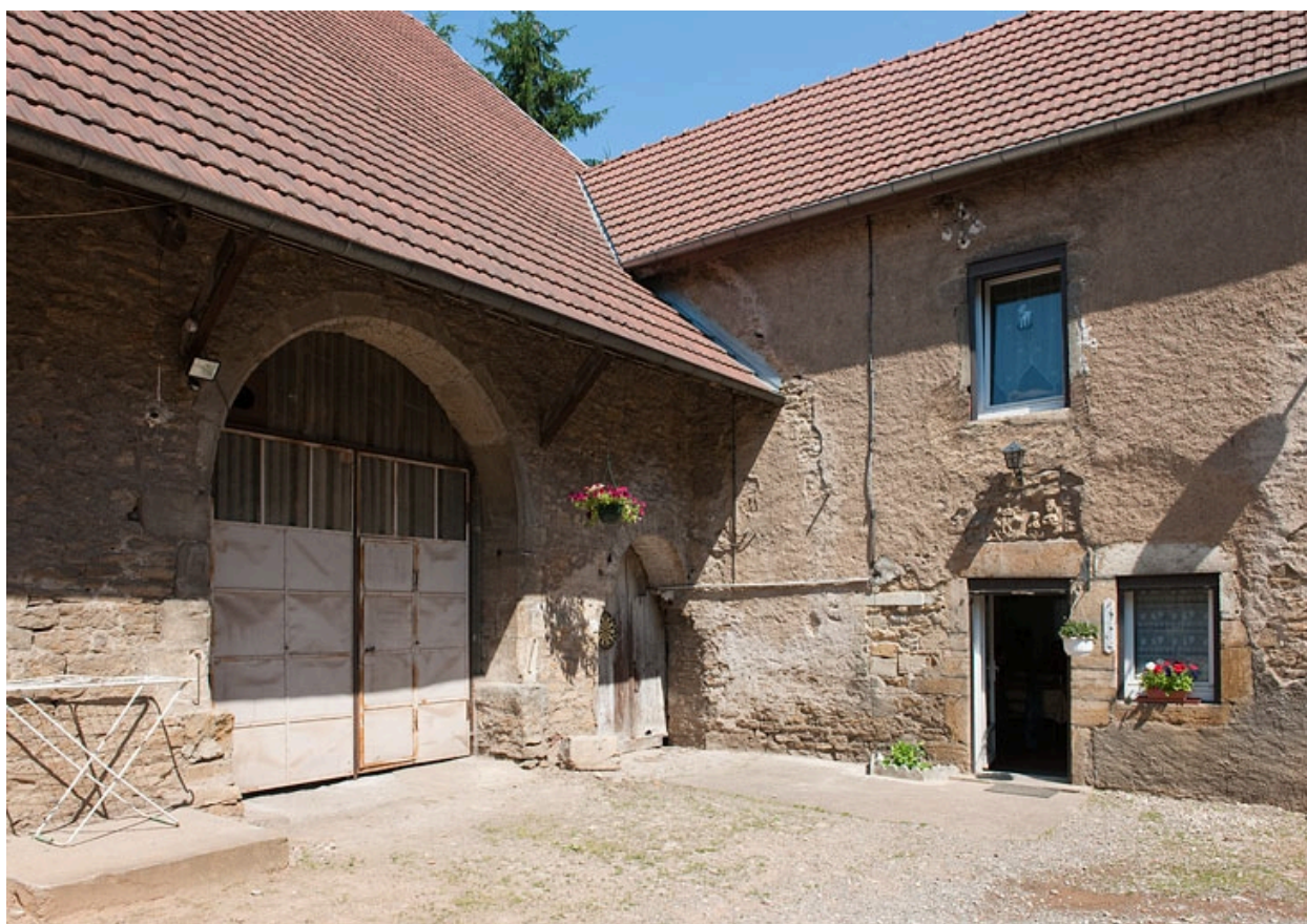
Ferme au 7 rue du Vieux Moulin (2010 AK 187) : grange et logis.
