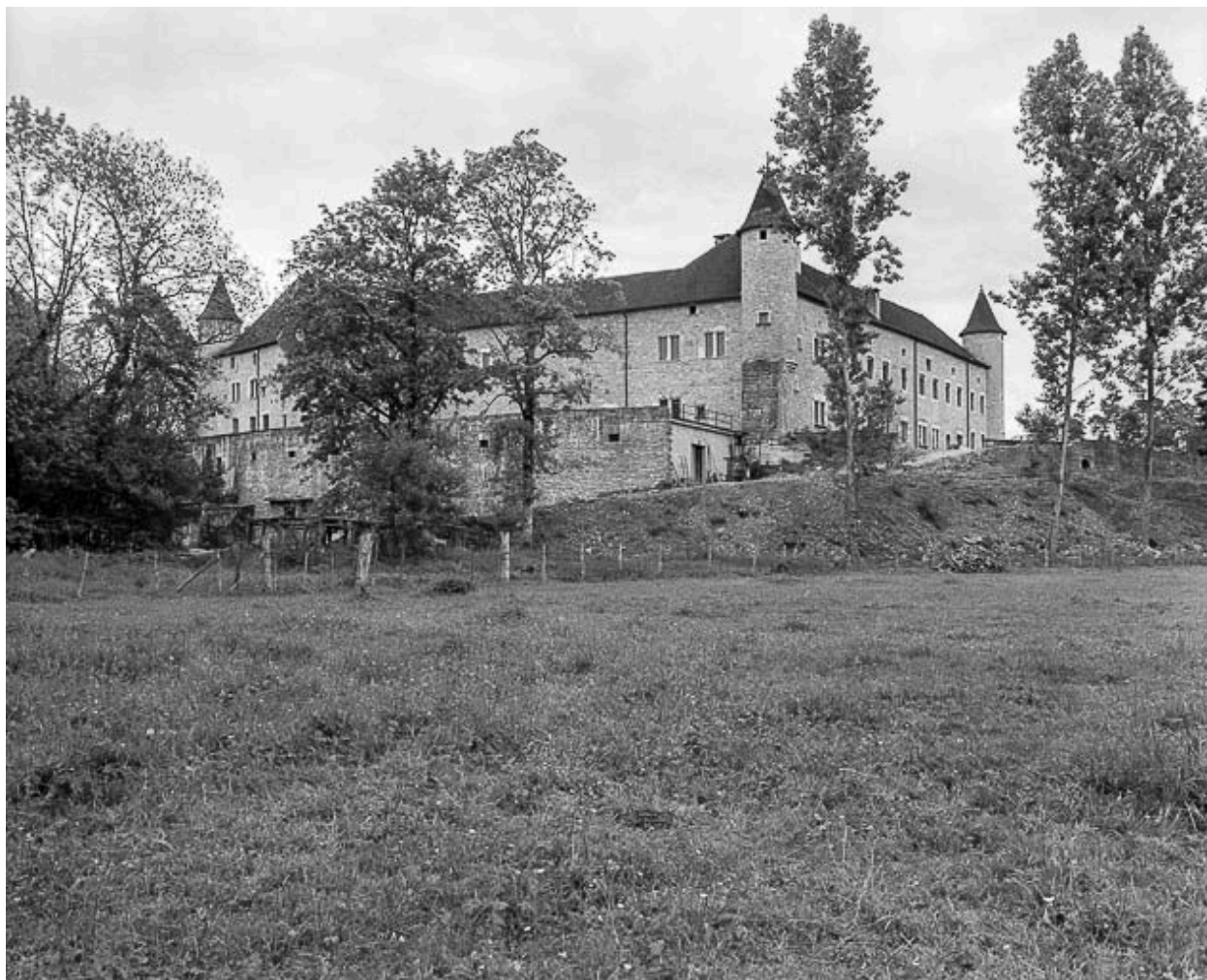
Façades nord et ouest.
