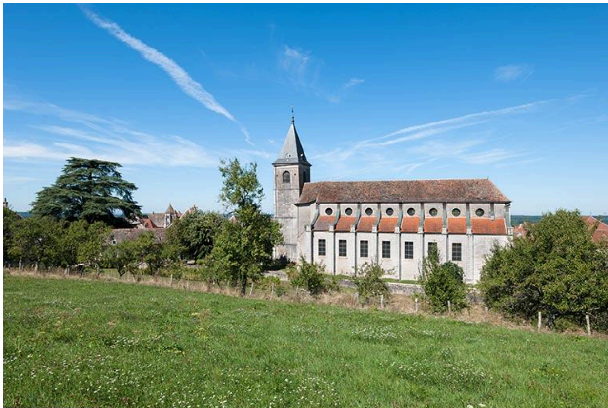
Vue générale sud de l'église
