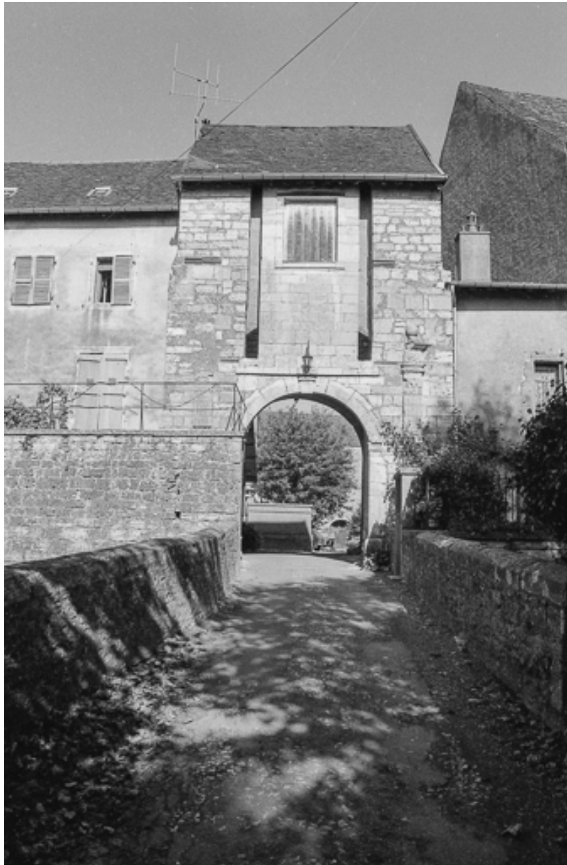
Ouvrage d'entrée : façade extérieure.
