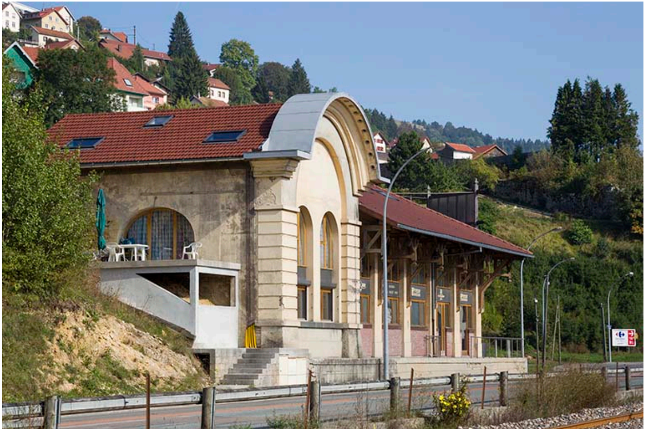
Ateliers de traitement des fûts (à gauche) et de conditionnement : façade orientale, vue en enfilade.
