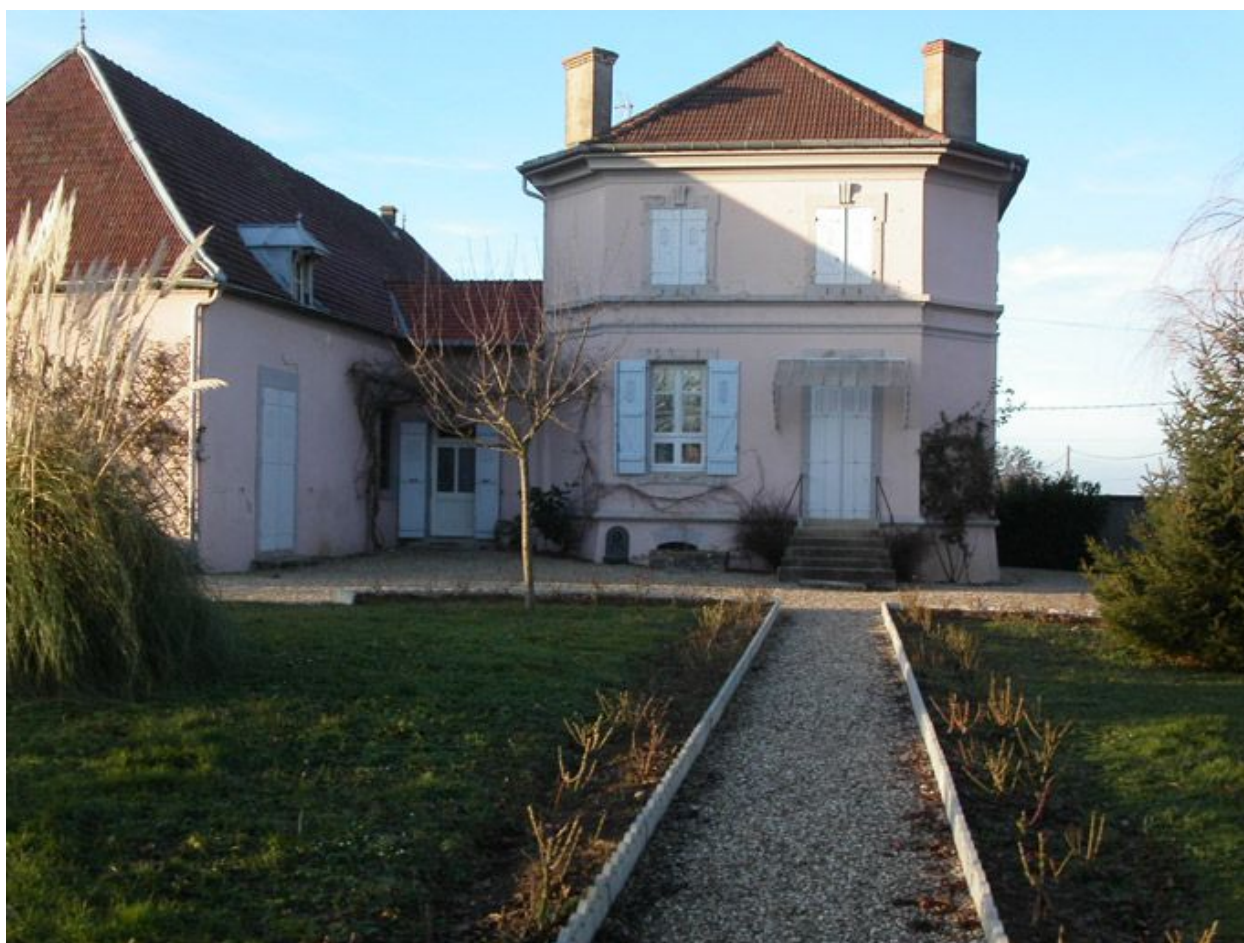
Vue d'ensemble de la façade.
