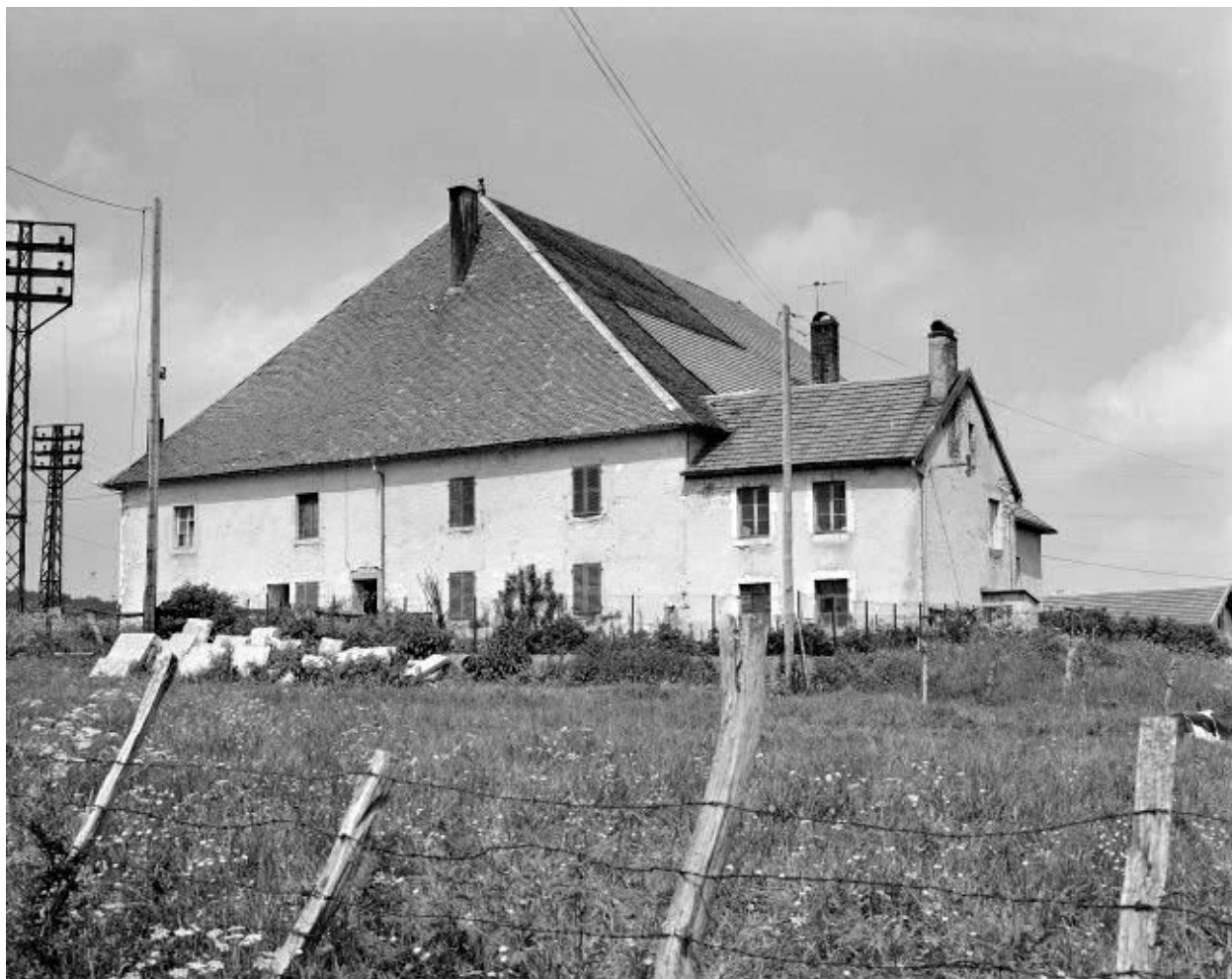
Ferme située à Renédale.
