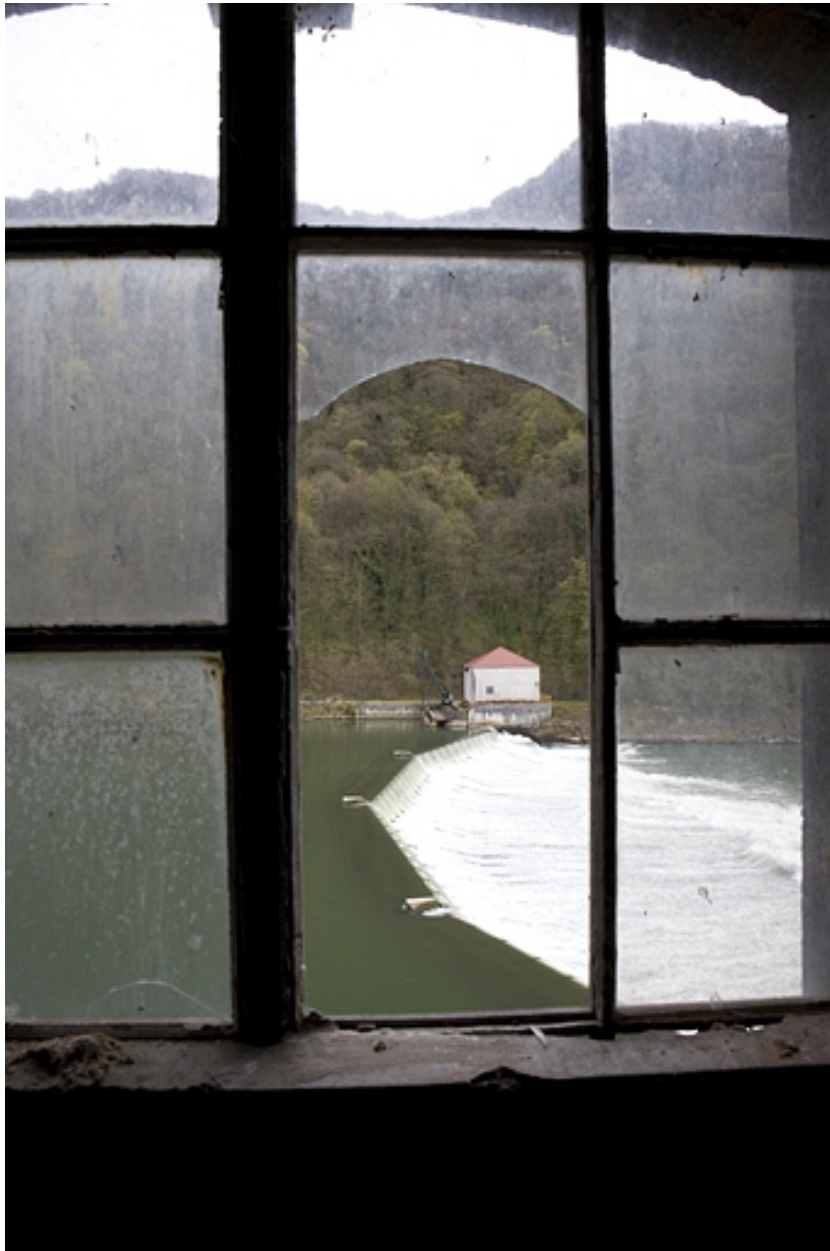
Vue du barrage depuis la rive droite.
