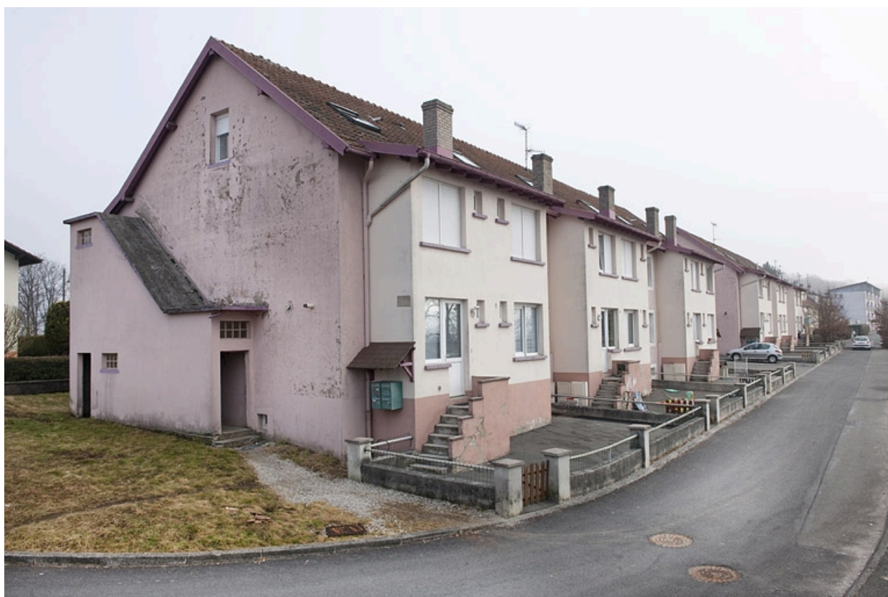
Immeubles d'habitation vus depuis l'ouest.
