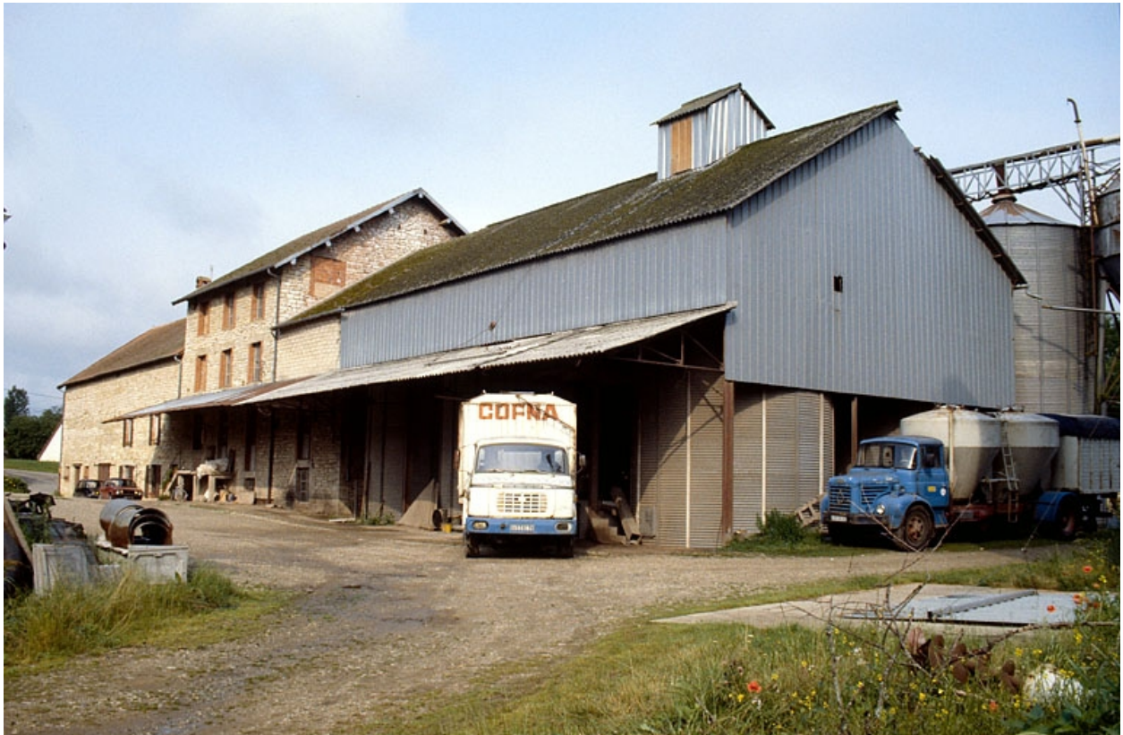
Hangar (E) et minoterie, depuis l'est.
