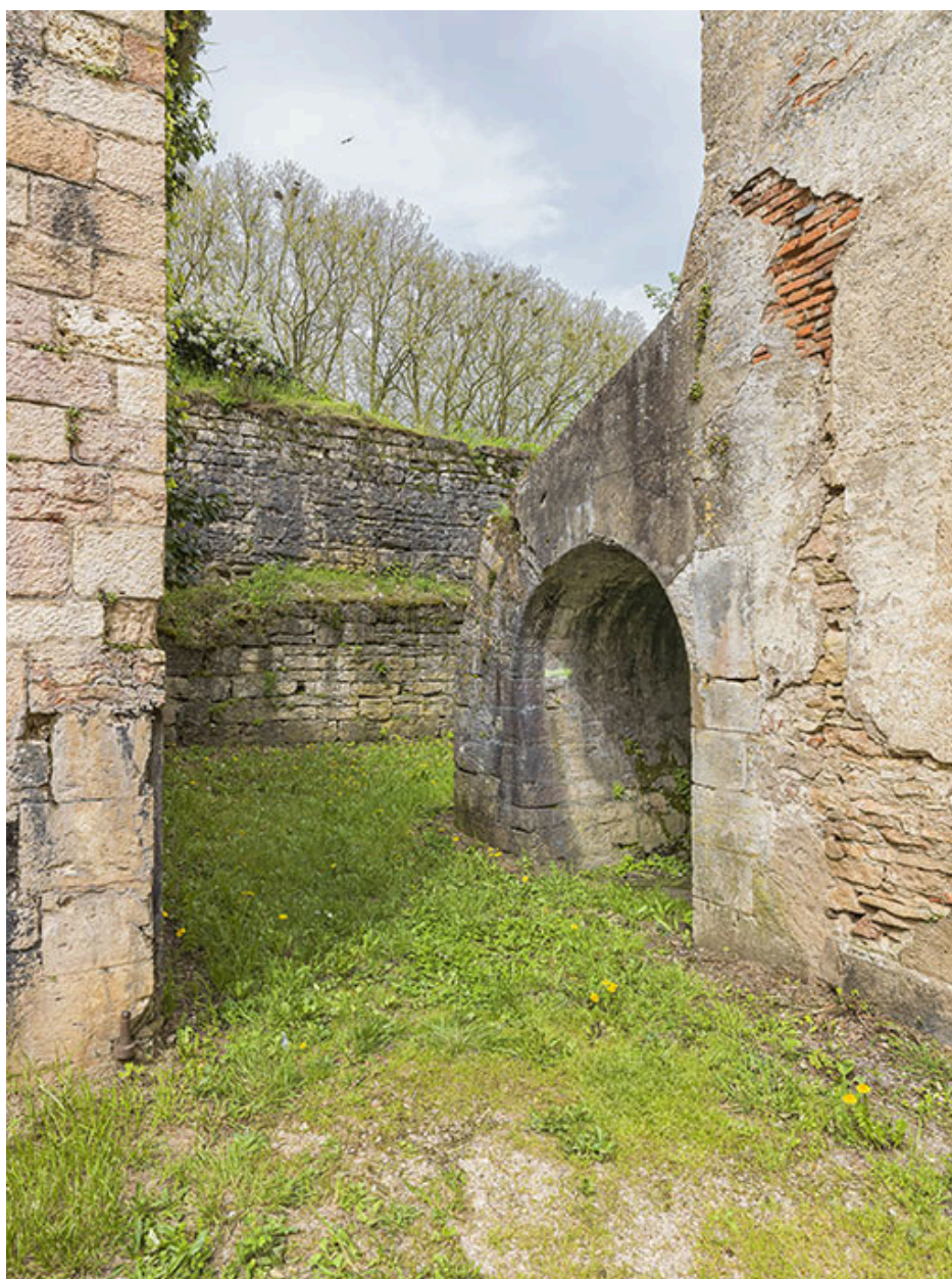
Galerie voûtée adossée à la caserne ouest du château.
