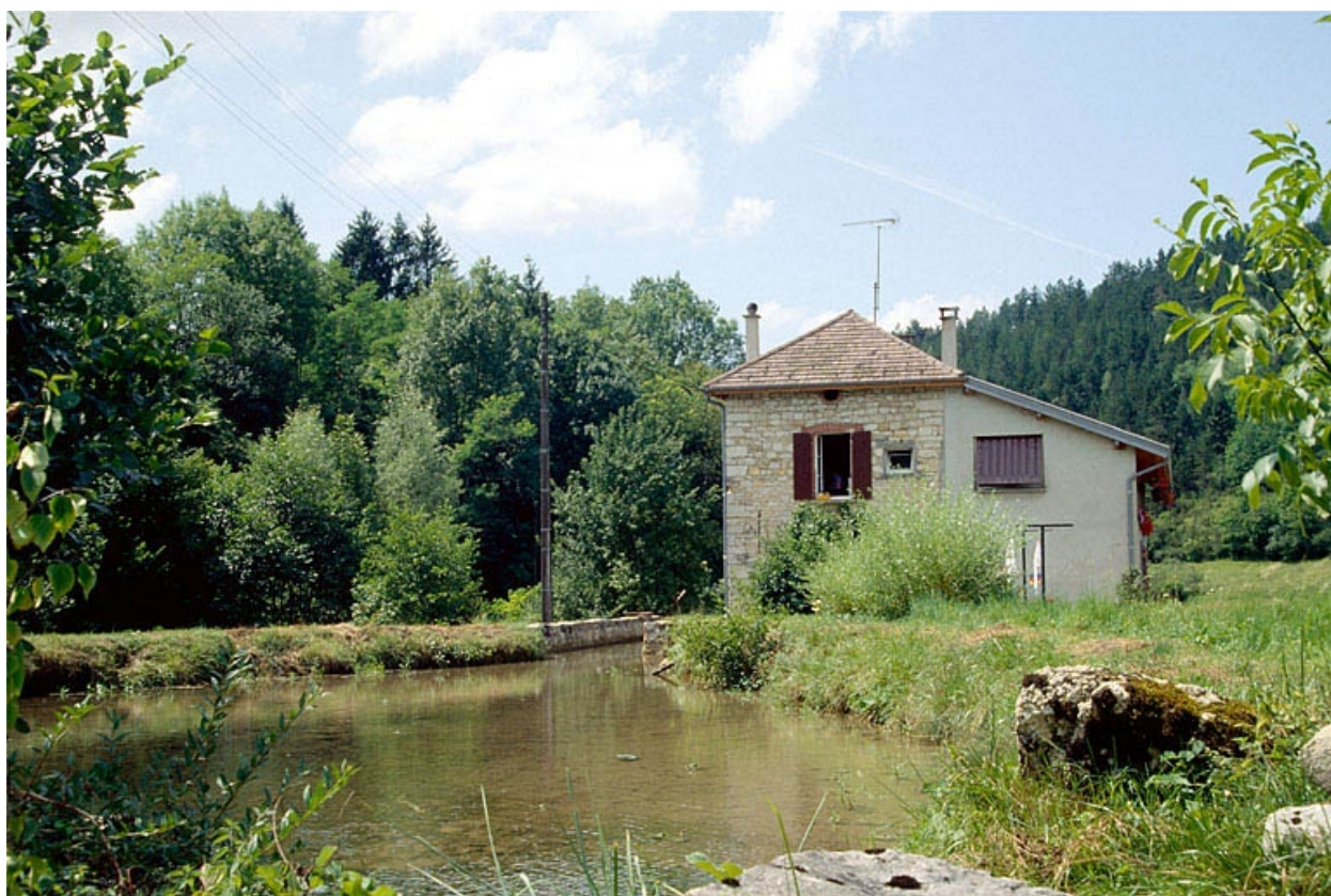
Bassin de retenue et façade latérale gauche.
