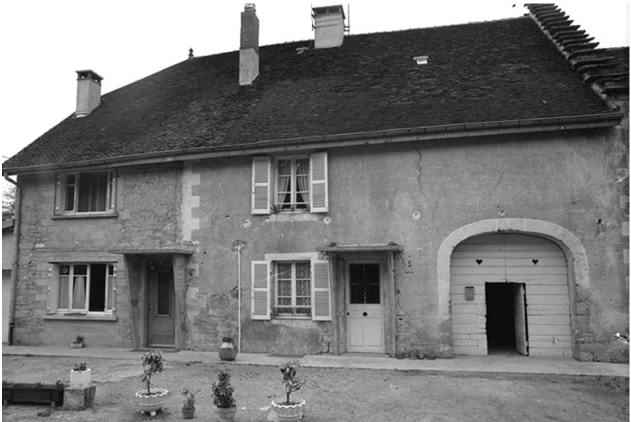
Maison cadastrée 1961 AH 199, située rue des Guichard : façade antérieure.
