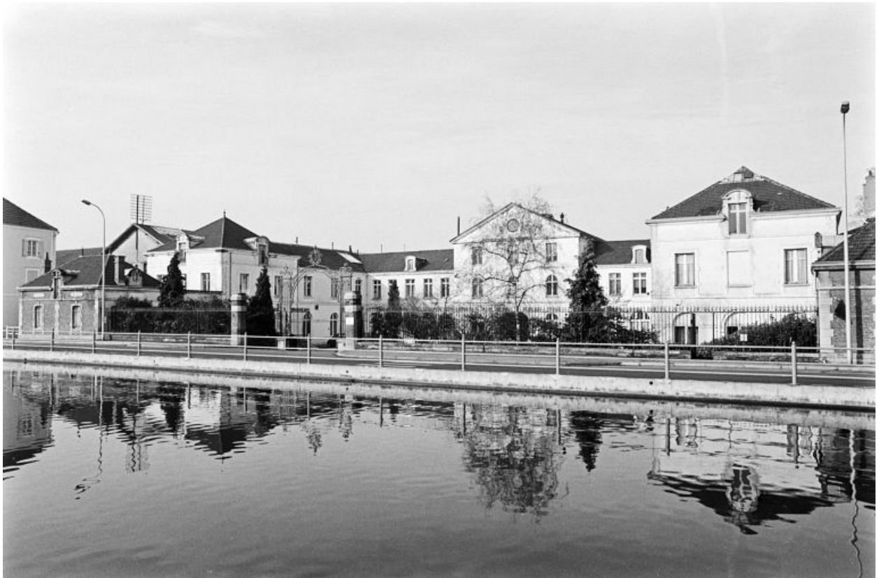
Façade antérieure des ateliers et bureaux centraux.
