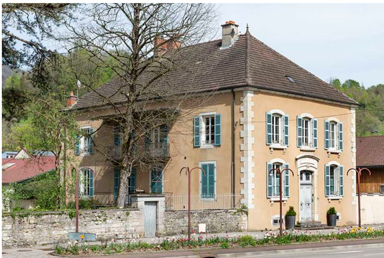
Vue depuis l'ouest.
