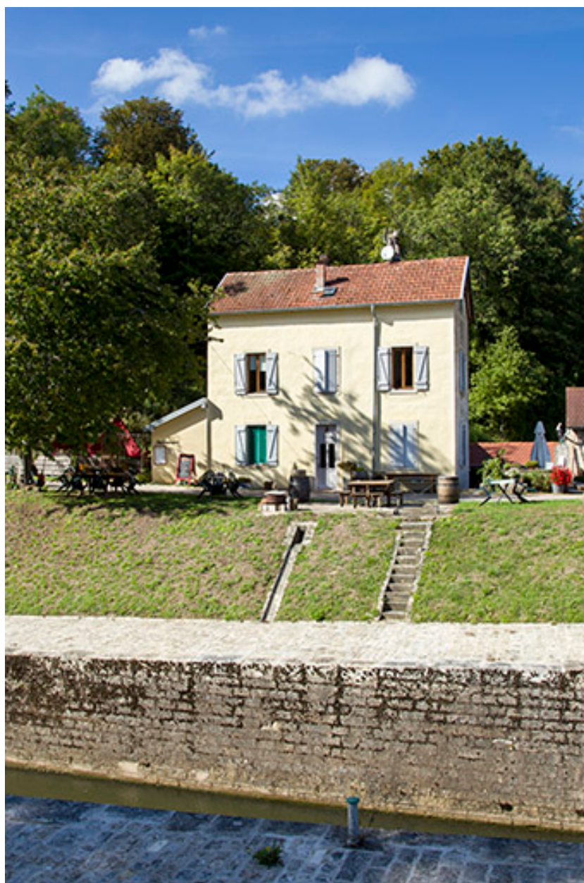
La maison du barragiste avec étage carré, dérivation souterrain de Saint-Albin.
