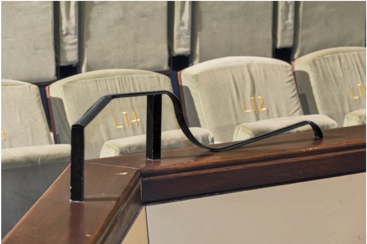
Salle, balcon : ferronnerie sur le garde-corps.
