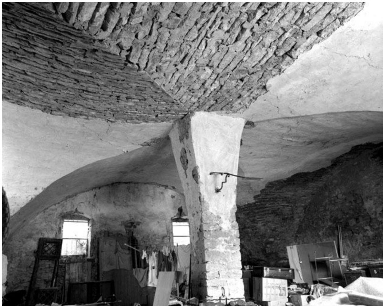
Pièce voûtée au rez-de-chaussée : la voûte.
