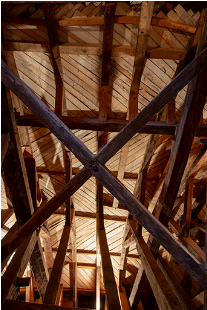
Partie nord depuis le niveau intermédiaire. Entretoise en croix de Saint-André.
