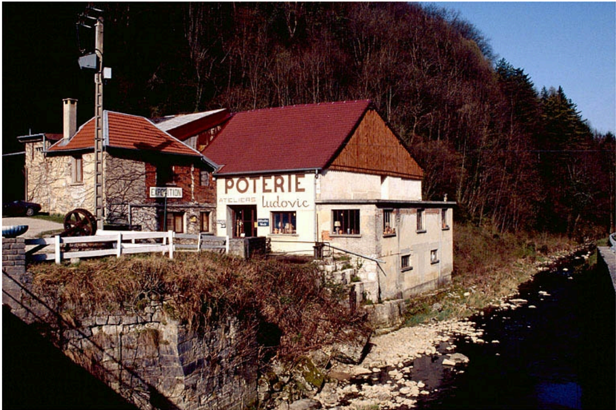
Atelier de fabrication depuis le pont.
