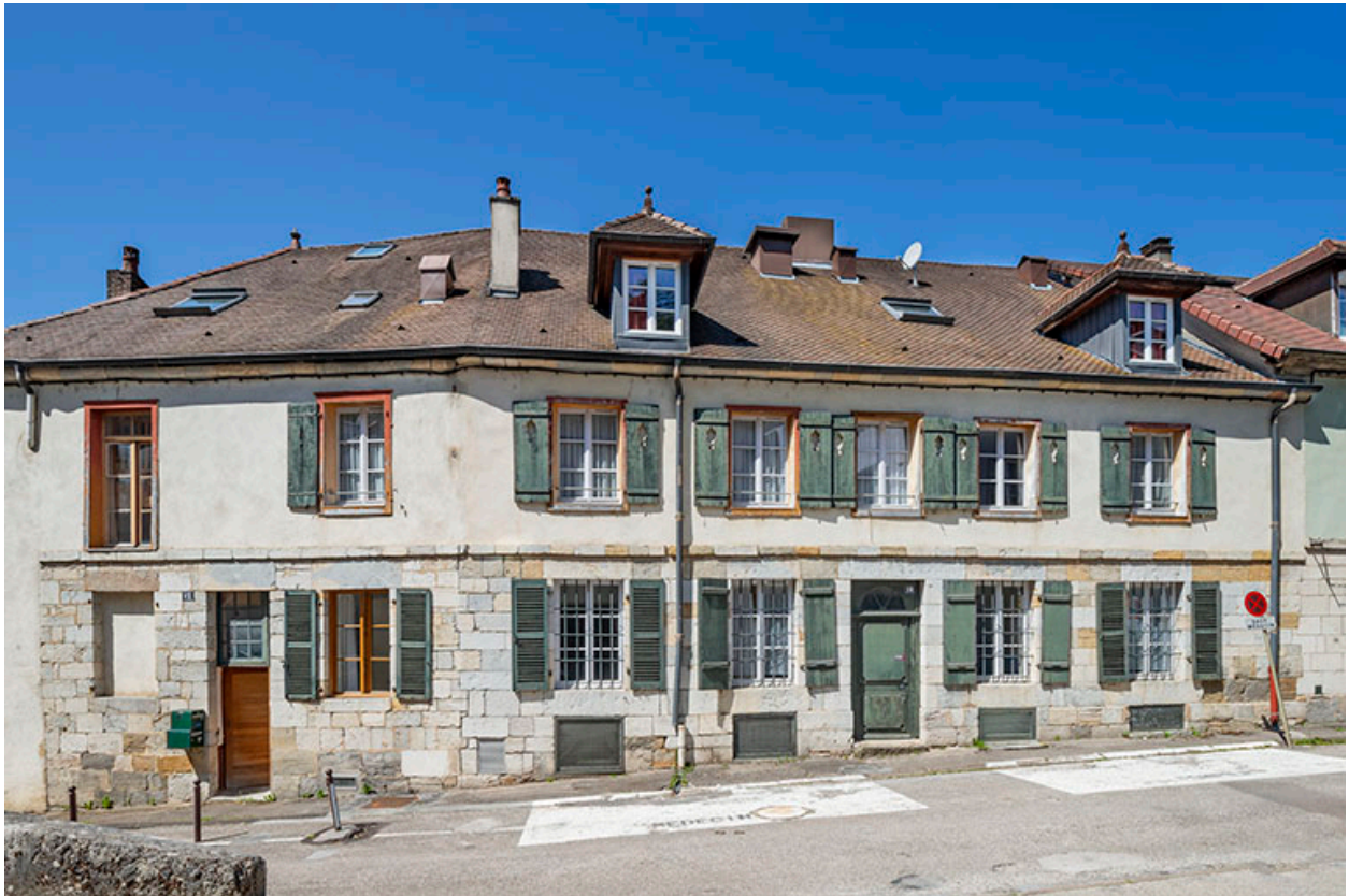
Façade sur la rue Considerant.
