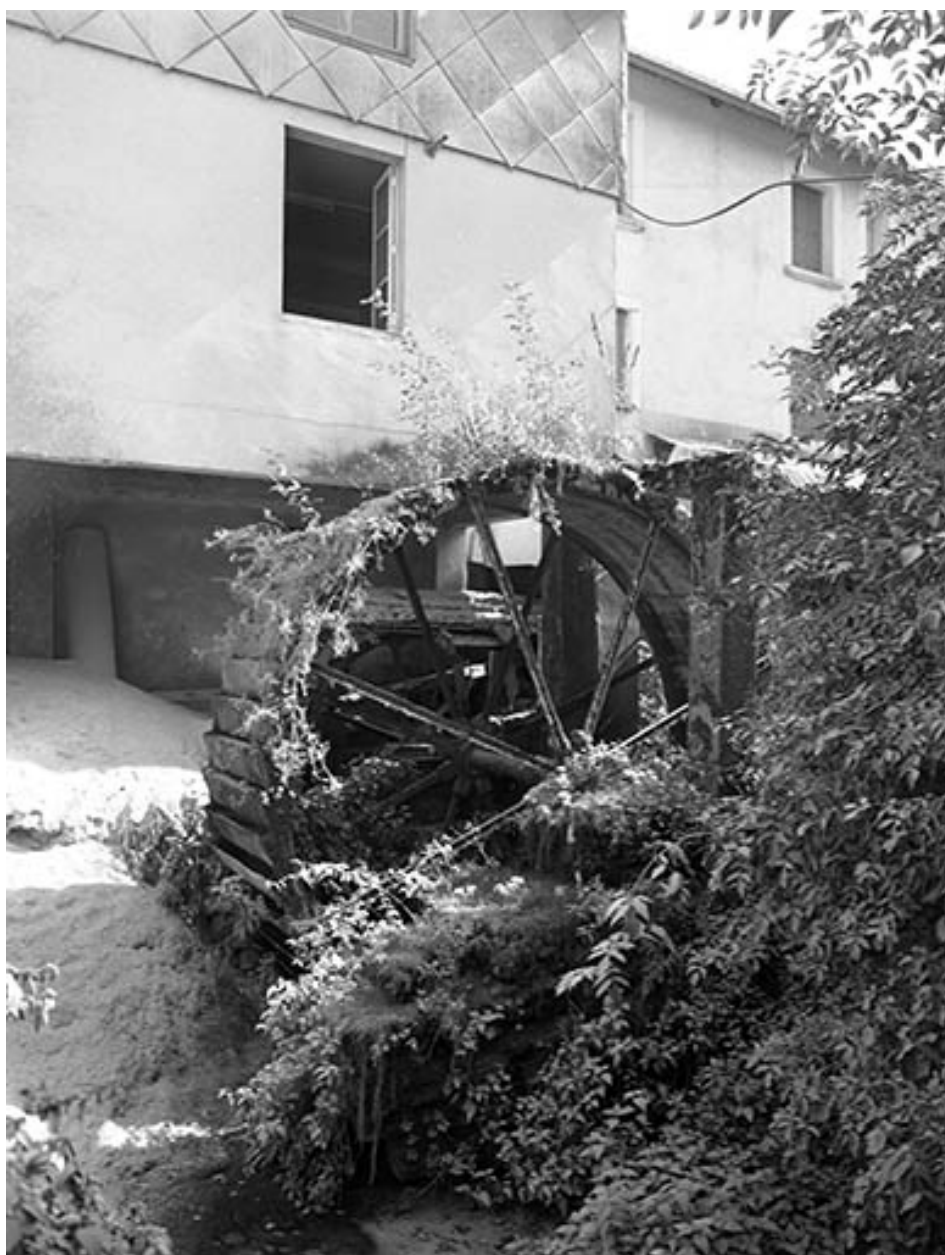
Roue hydraulique sur la façade postérieure.
