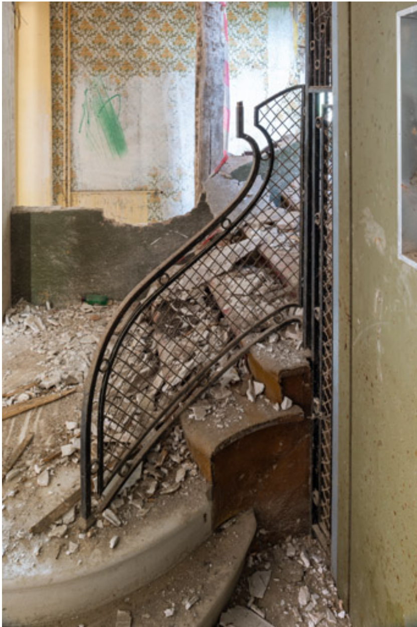
Escalier ouest, détail, rampe d'appui.
