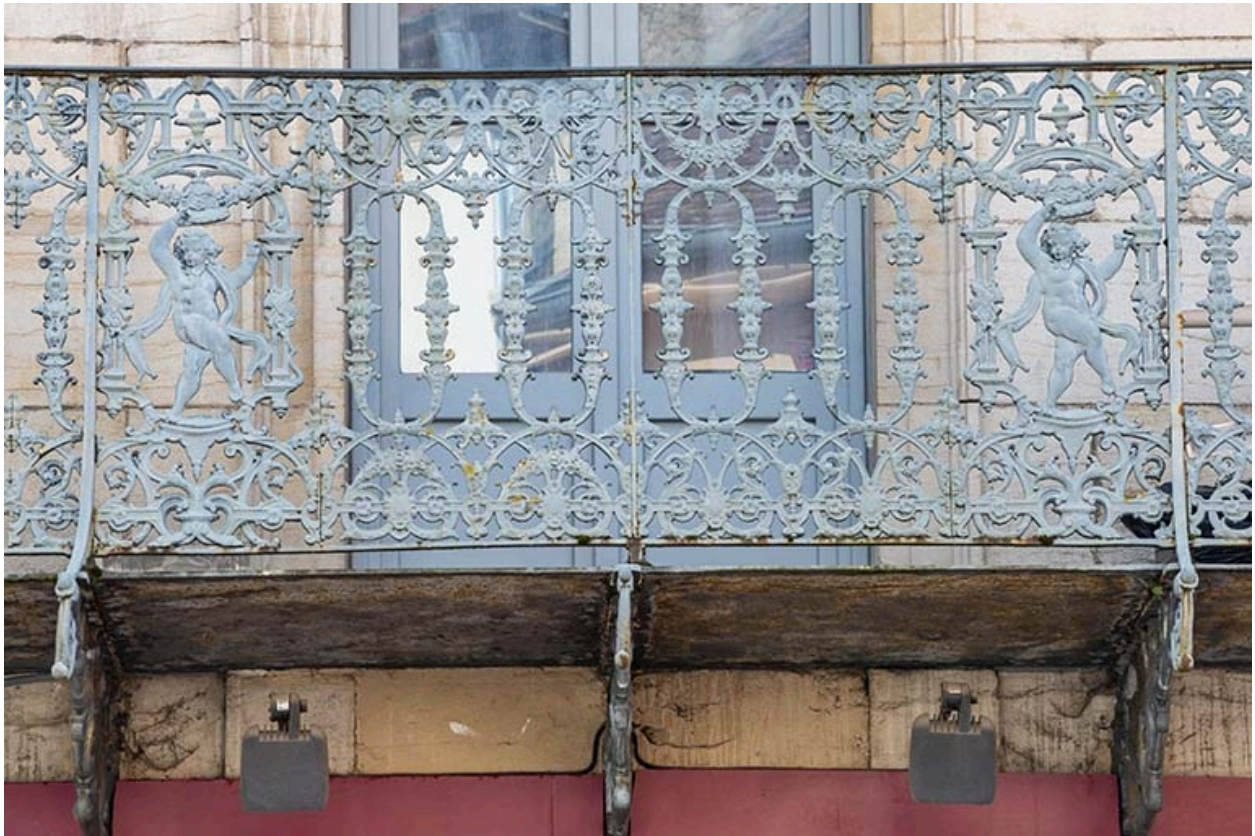
Détail du balcon du premier étage.
