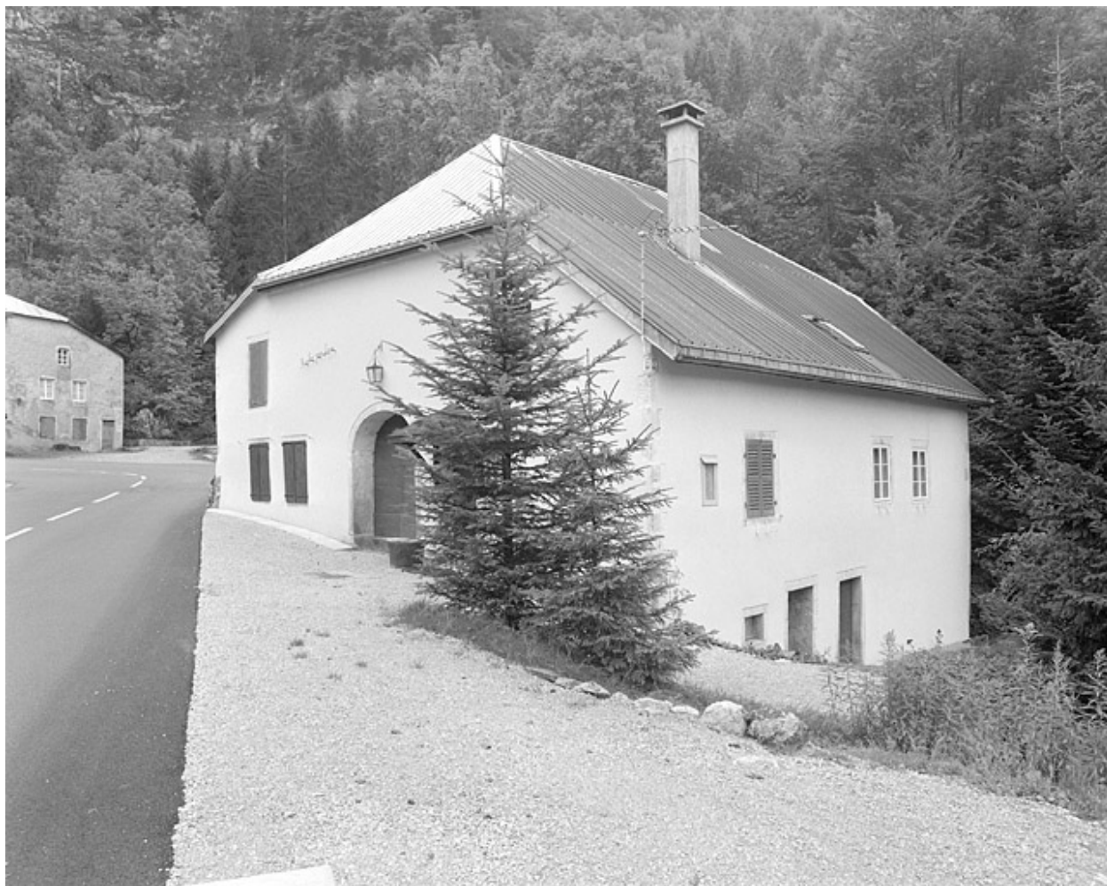
Façades nord-est et nord-ouest.
