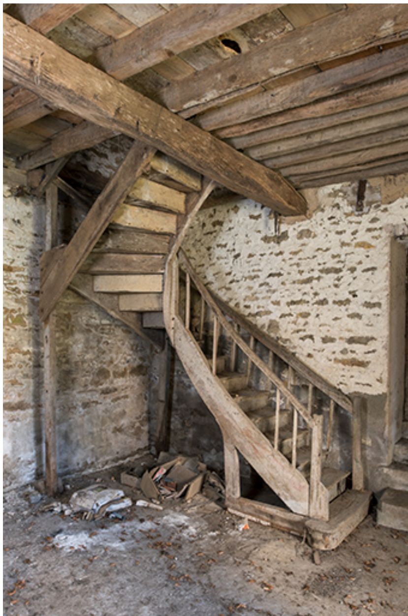
Bâtiments agricoles au sud de la cour : accès au grenier.
