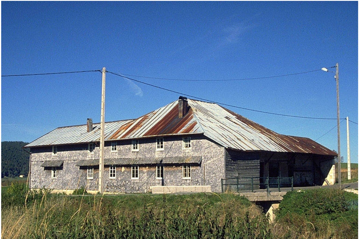
Bâtiment vu de trois quarts gauche.
