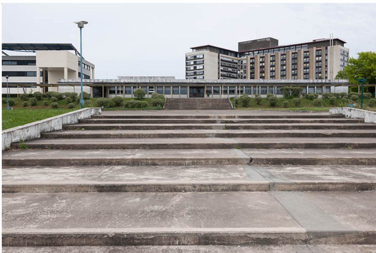
Façades postérieures des bâtiments d'externat et restauration
