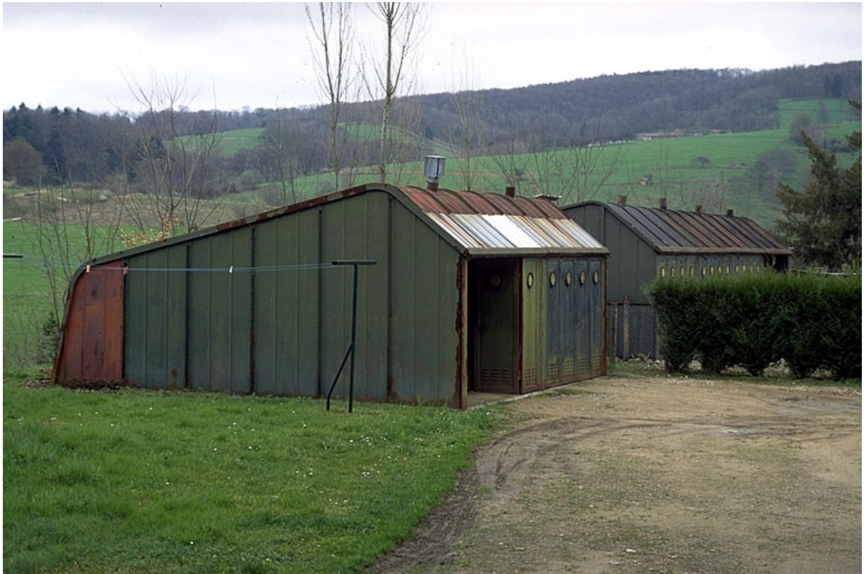
Remises d'automobile métallique : vue d'ensemble.
