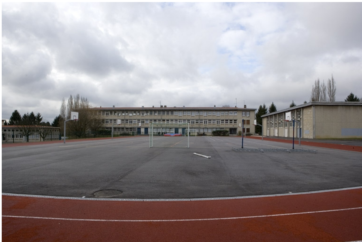
Vue d'ensemble bâtiment F2 et C.
