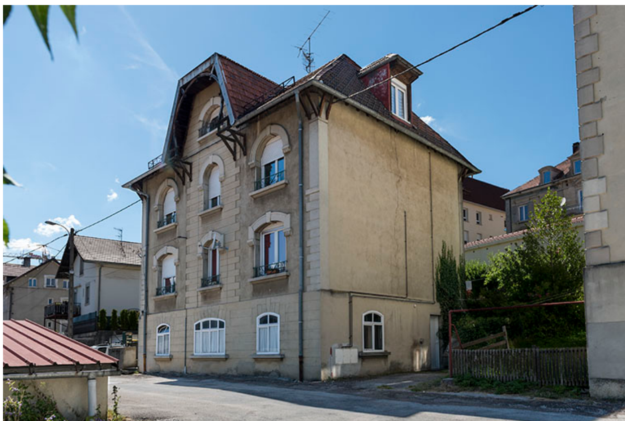
Façades antérieure et latérale droite.
