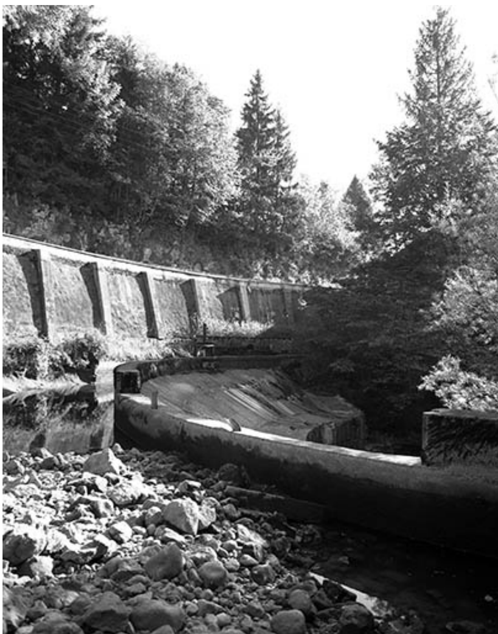
Bassin de retenue (à sec) et barrage.
