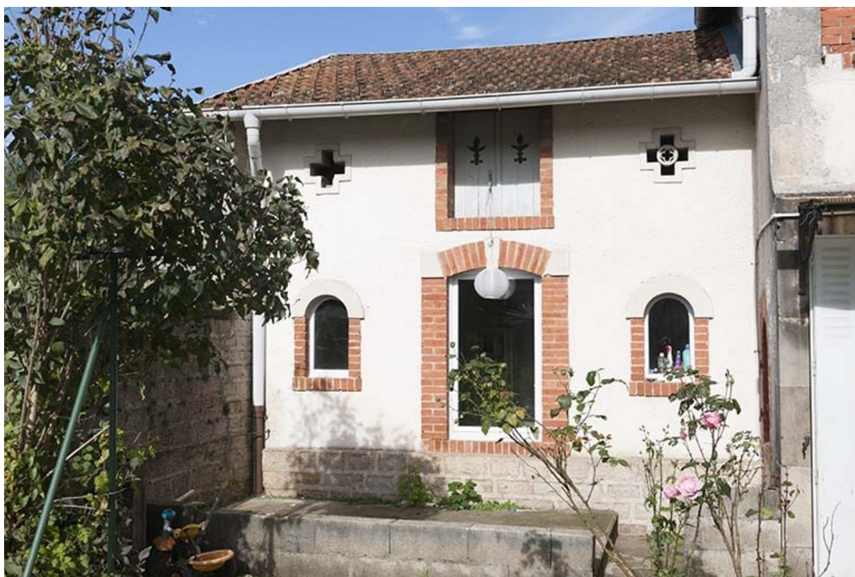
Façade antérieure de la remise.
