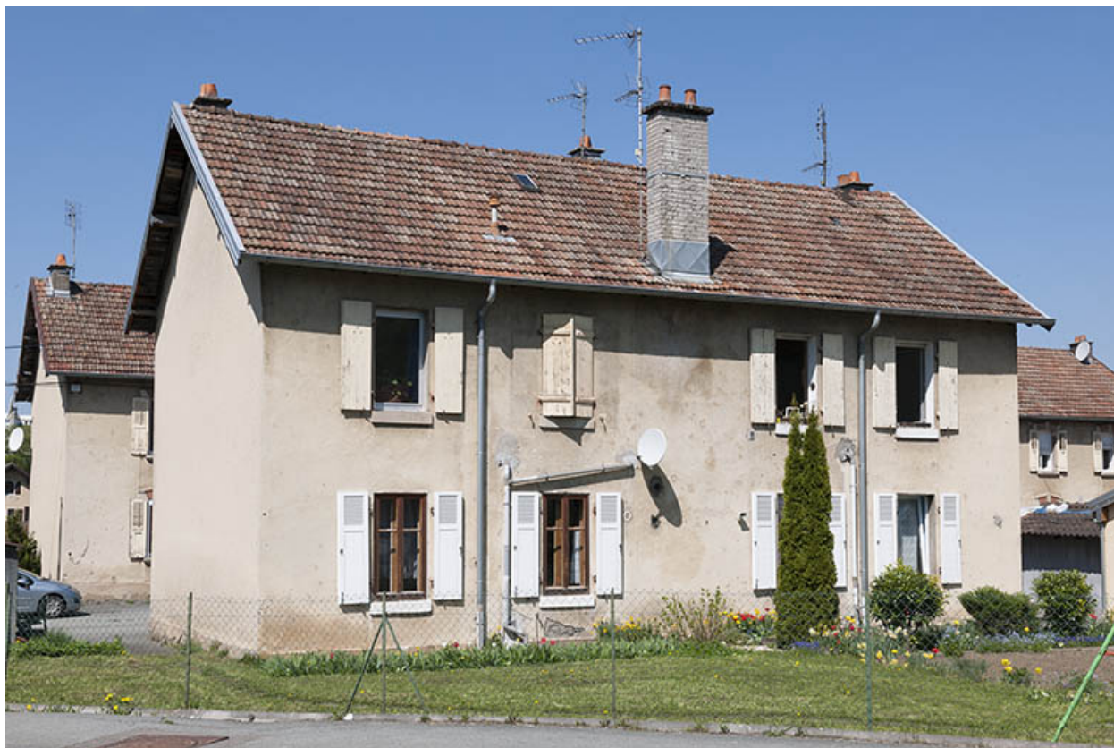
Façade postérieure d'une habitation.
