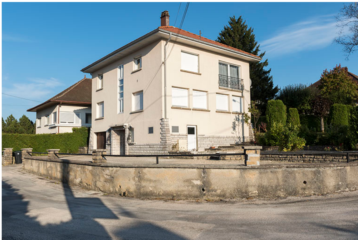
Vue d'ensemble (façades antérieure et latérale droite).
