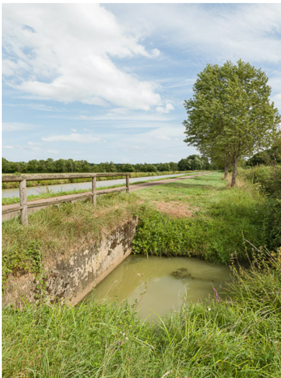
Vue de l'aqueduc.
