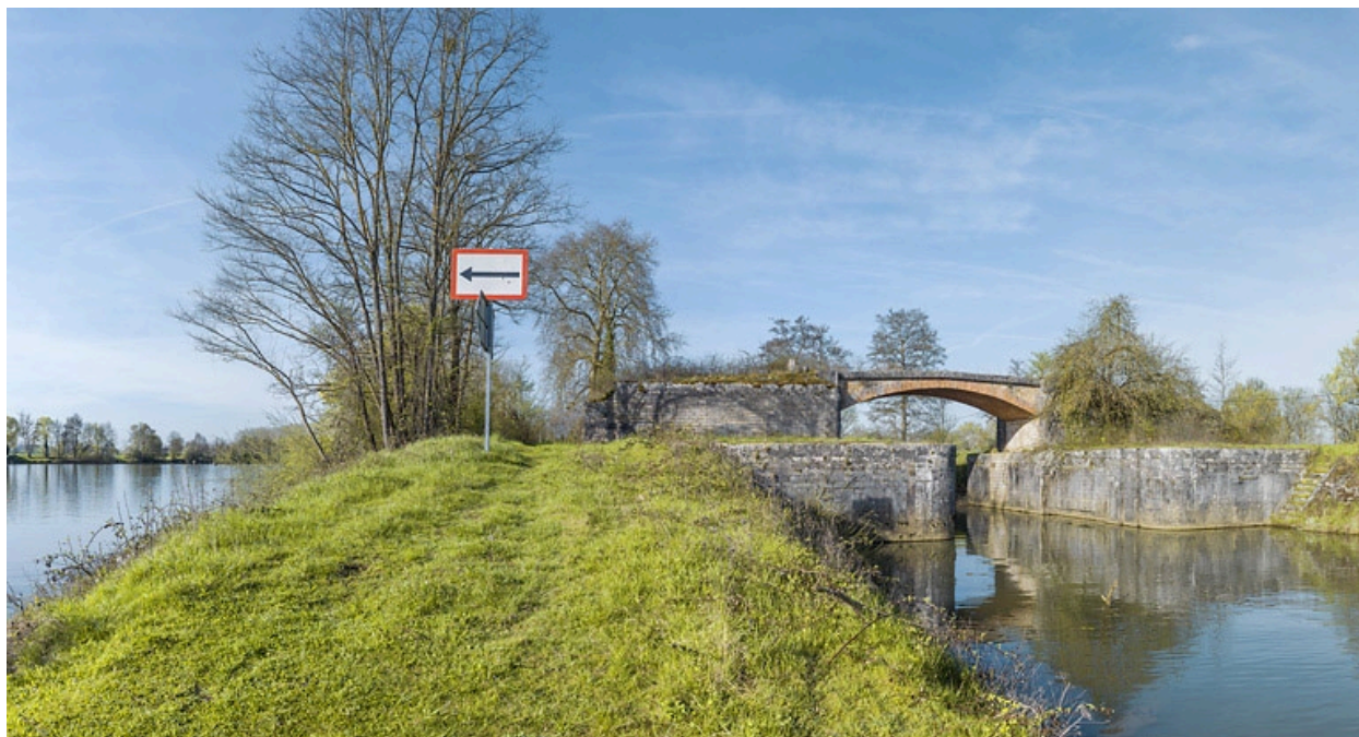
L'entrée de l'ancienne dérivation, rive droite.
