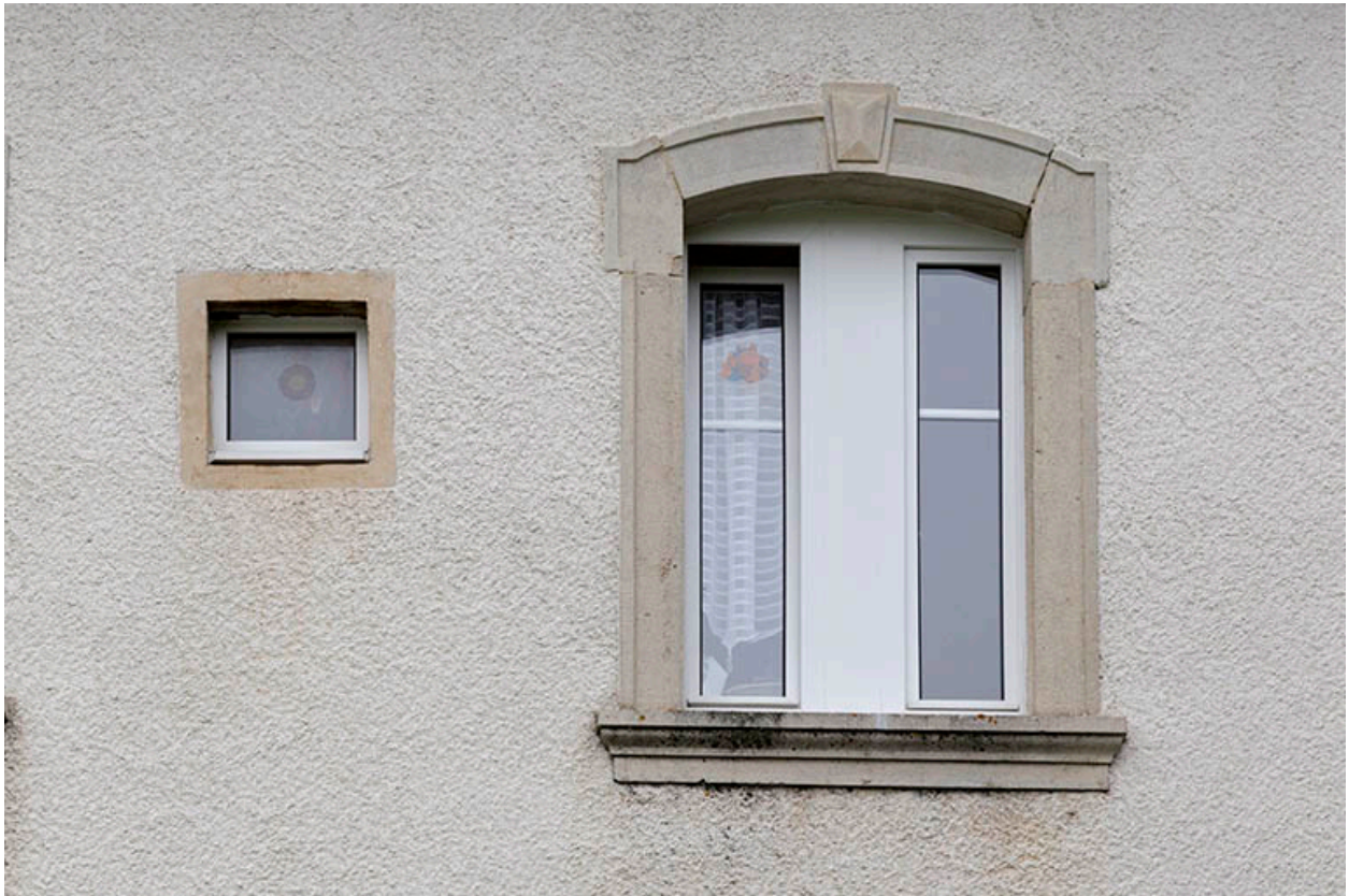
Logement patronal, façade postérieure : fenêtre du 1er étage.
