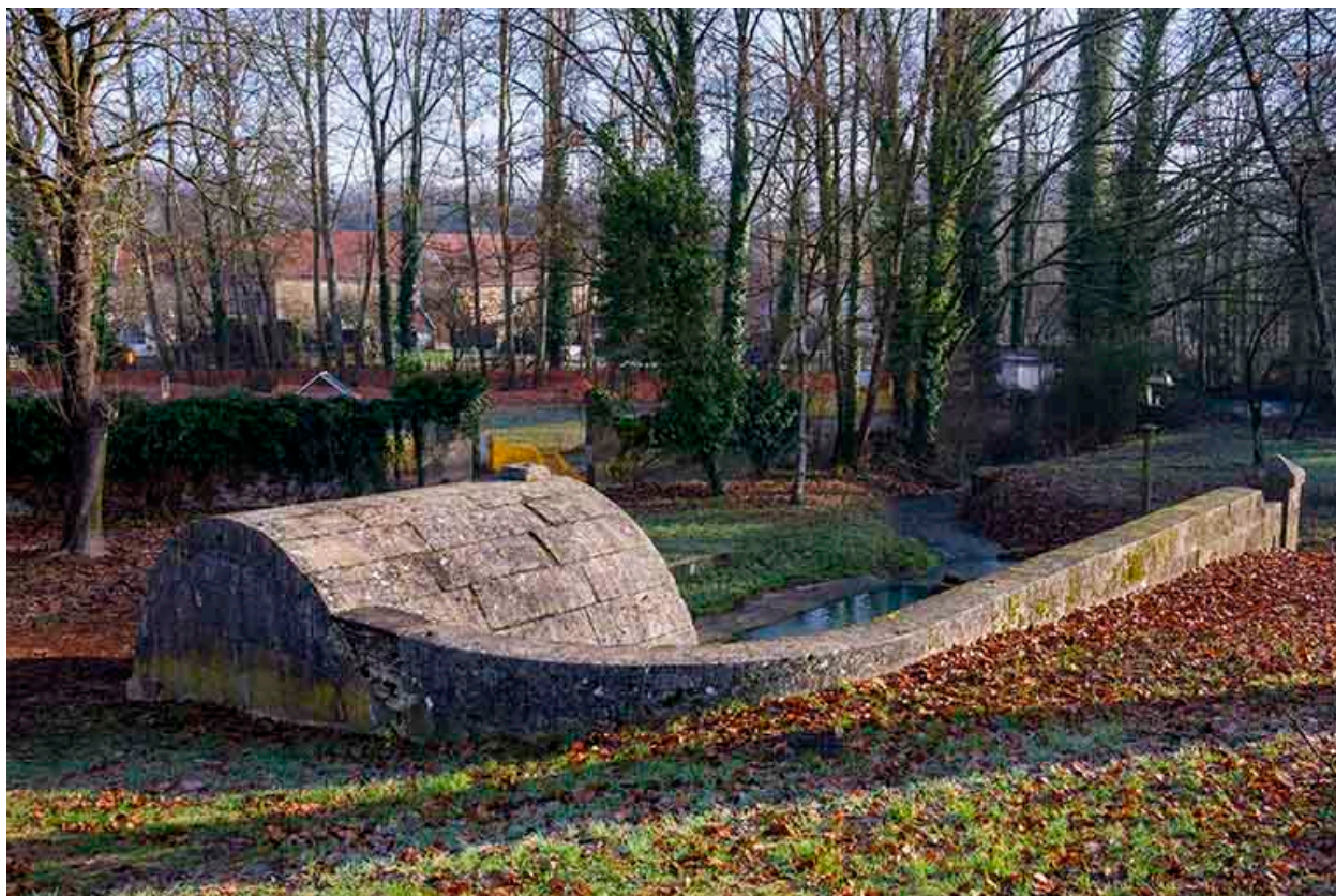
Mur de soutènement, vue depuis le nord.
