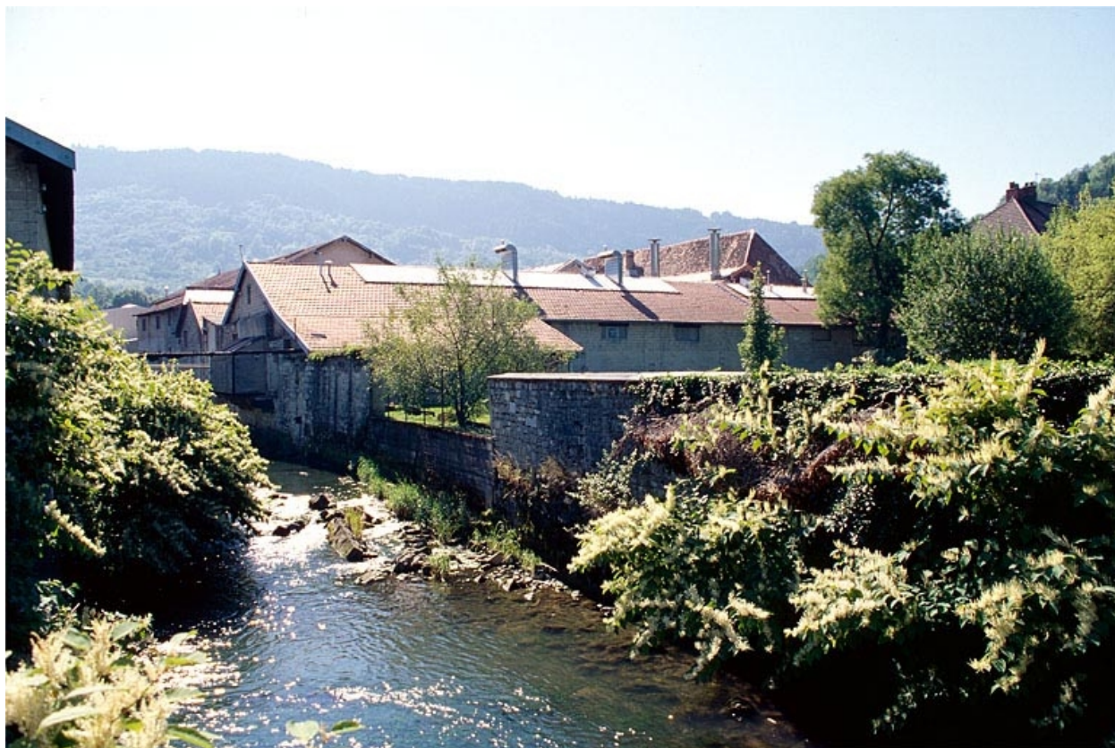
Façades postérieures depuis la Furieuse en aval.
