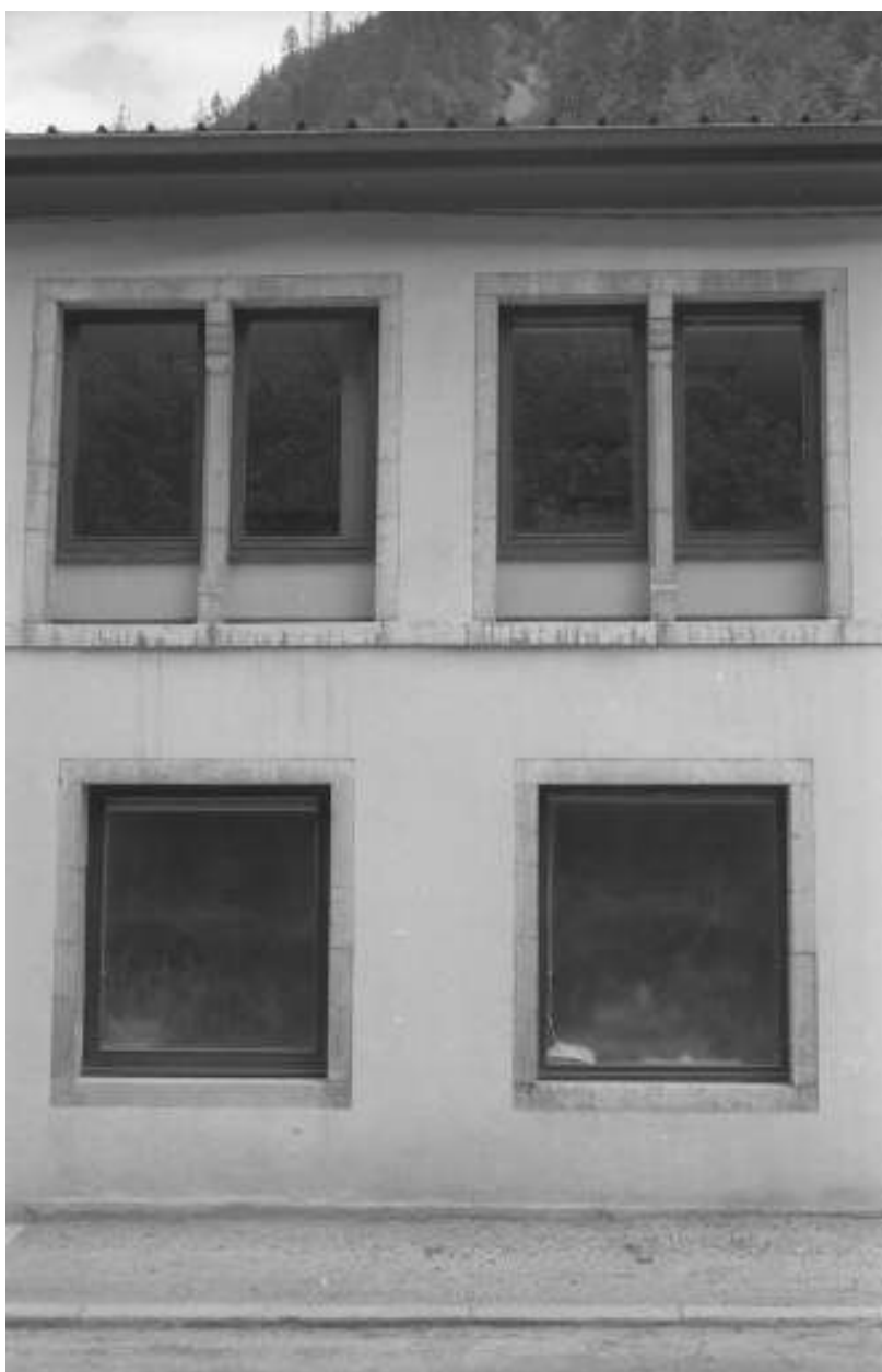
Fenêtres de l'atelier de fabrication des années 1850.
