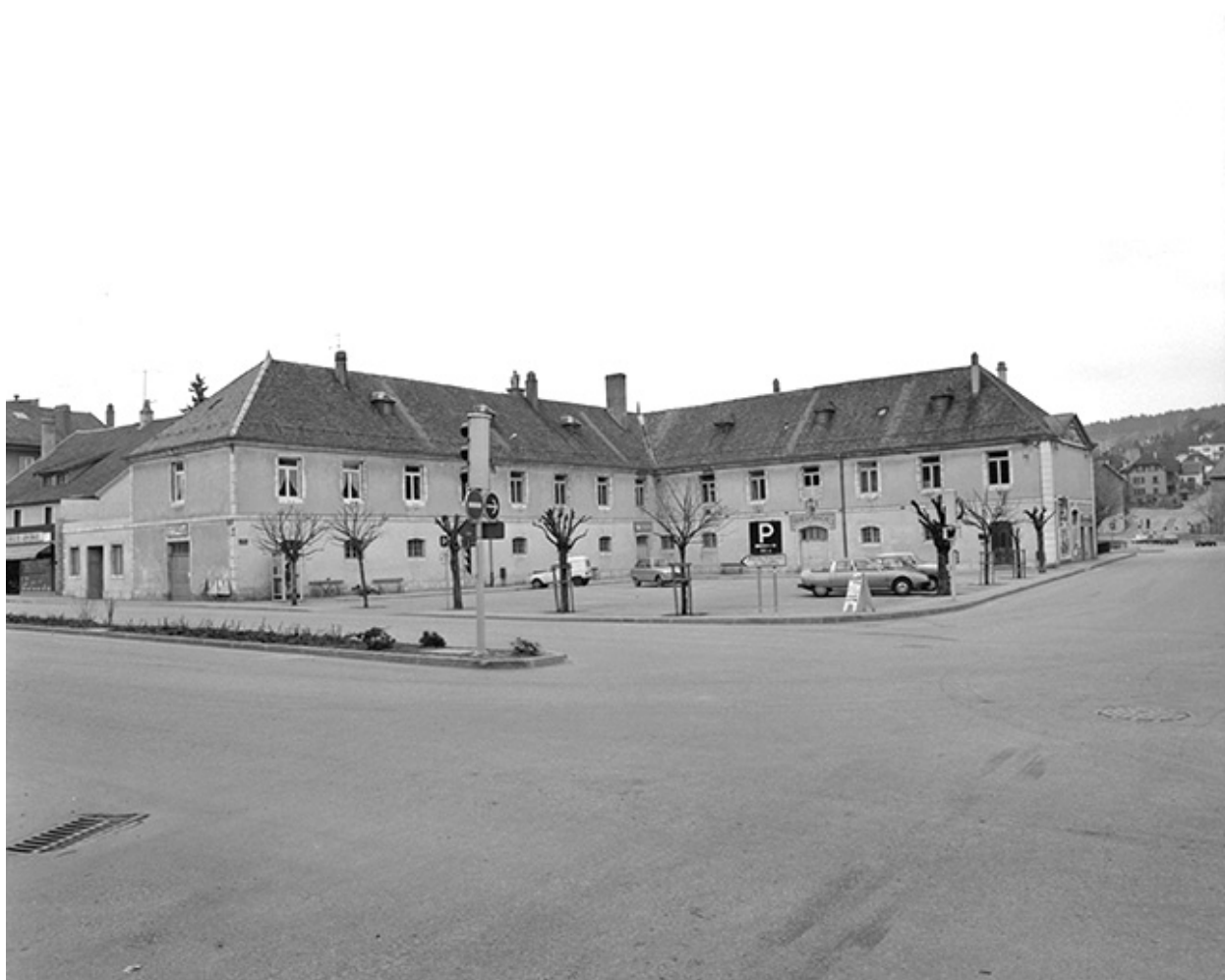
Corps de bâtiment gauche.
