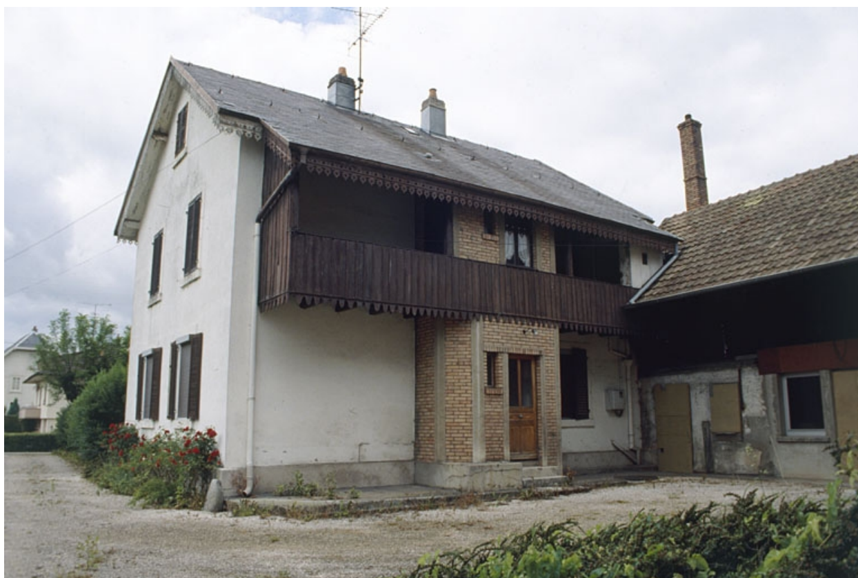
Façade sur cour du logement.
