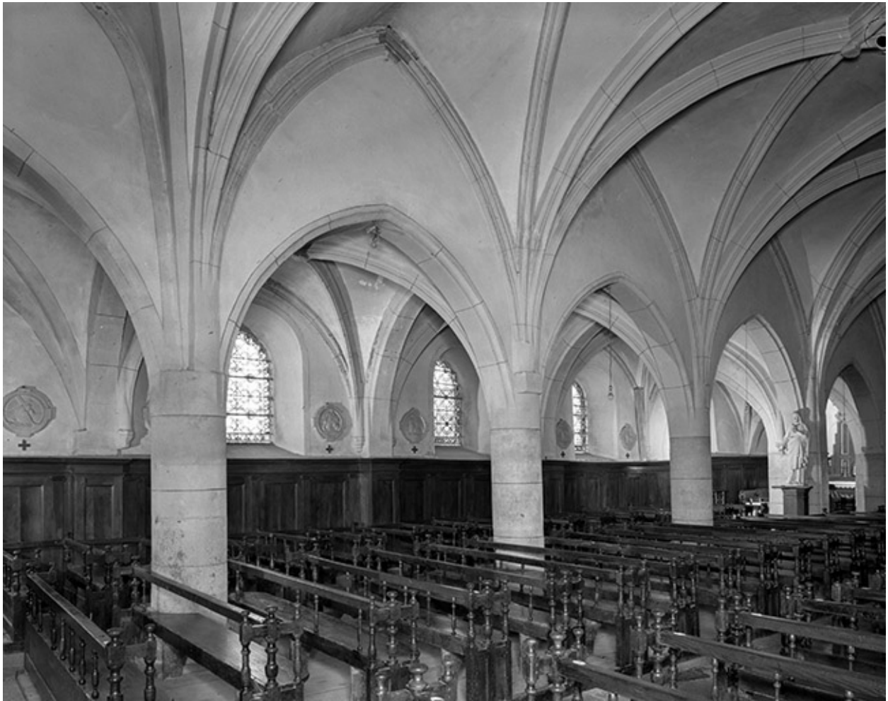
La nef, élévation nord en 1976.
