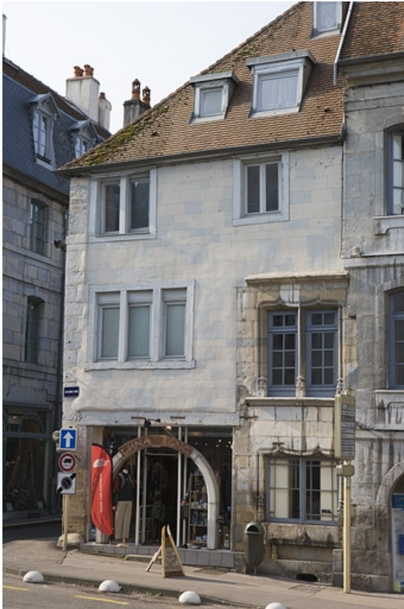
Vue d'ensemble de la façade sur la Grande Rue, de trois quarts droite.
