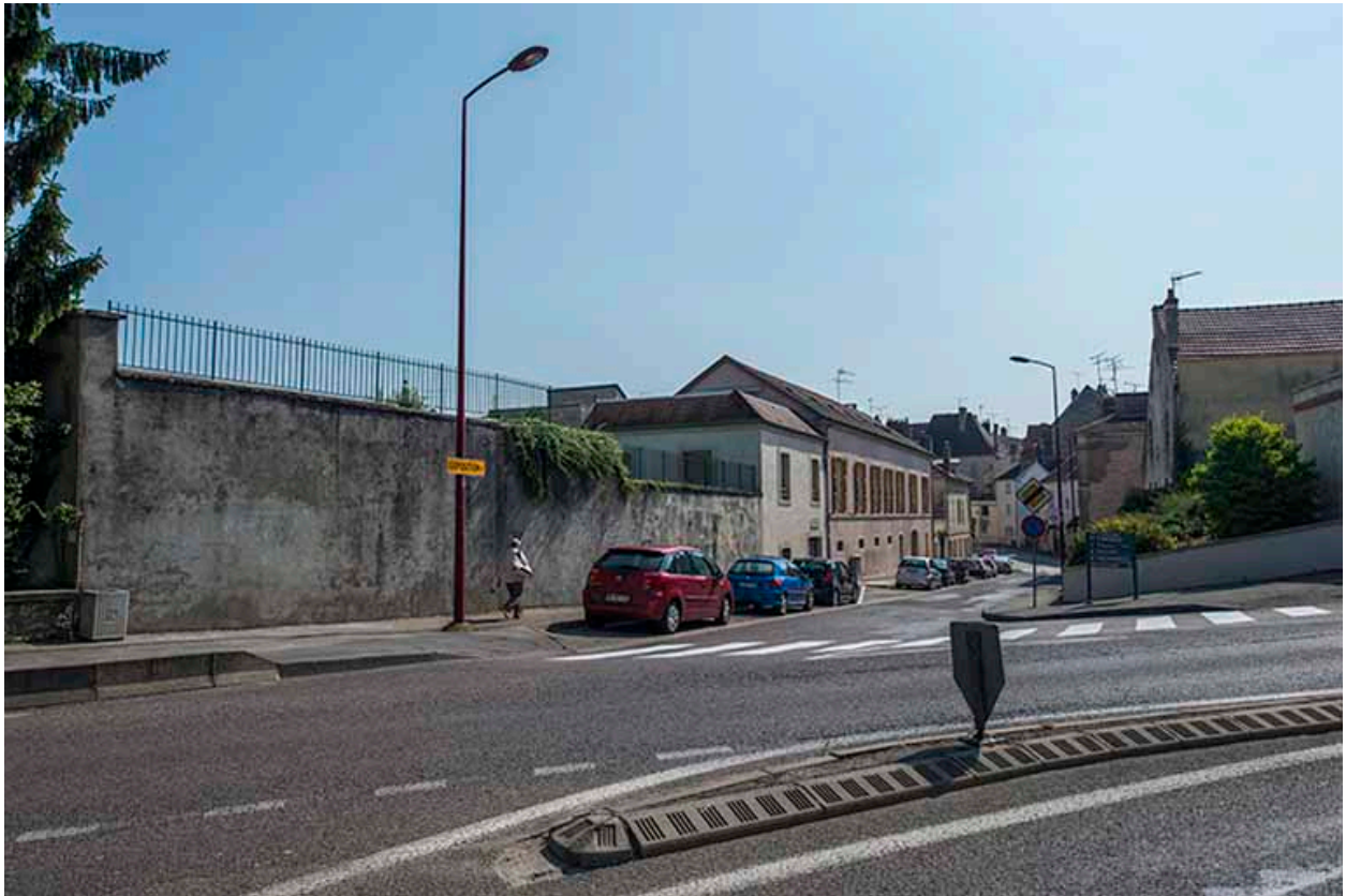
Vue d'ensemble depuis l'ouest sur la façade antérieure de la cantine, rue Rossen.
